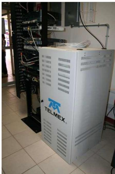
**Figura 27.** Equipo al que llega la fibra óptica y la señal de internet
